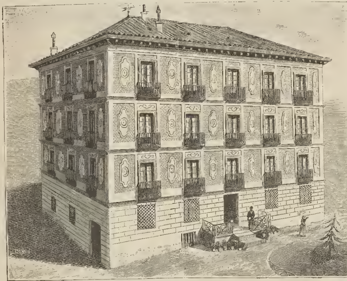
Edificio en el manantial de CARABAÑA
